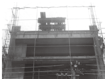
建設中の名演会館
